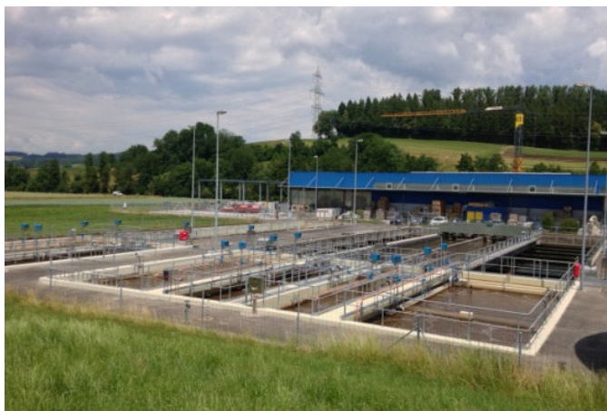
Bild 3: Abwasserreinigungsanlage oberes Surbtal. Der biologische Behandlungsteil der Anlage besteht aus drei identischen Straßen.
