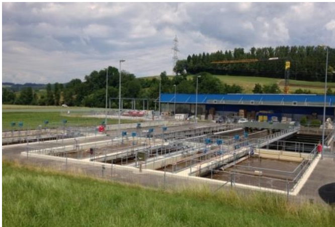
Bild 3: Abwasserreinigungsanlage oberes Surbtal. Der biologische Behandlungsteil der Anlage besteht aus drei identischen Straßen.
